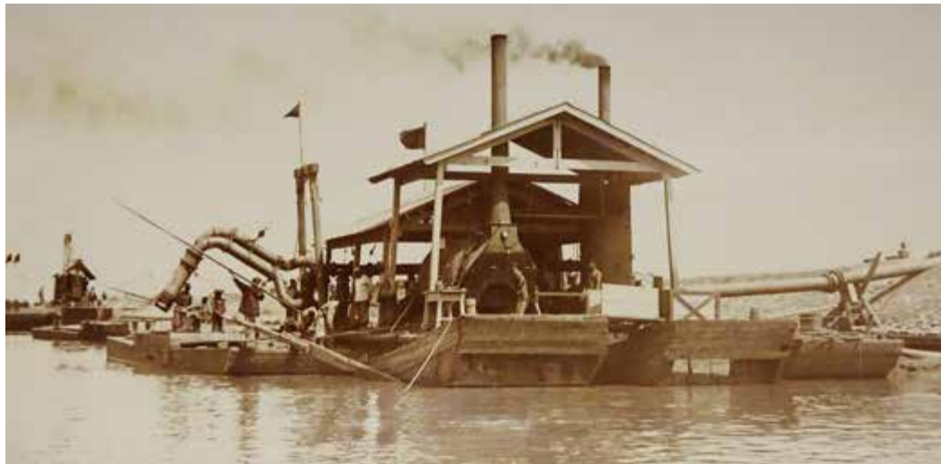
海河边的比利时挖泥船正在作业, 抽取水底淤泥到河岸上以垫平土地、修整河岸。照片摄于 1911 年, 收藏于比利时外交部档案馆
