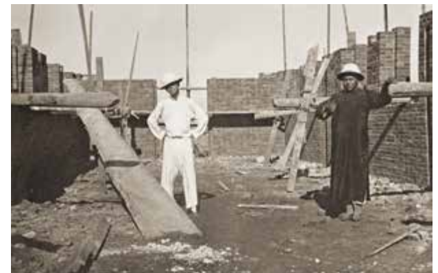
建设中的北疆博物院 Beijiang Museum under construction
