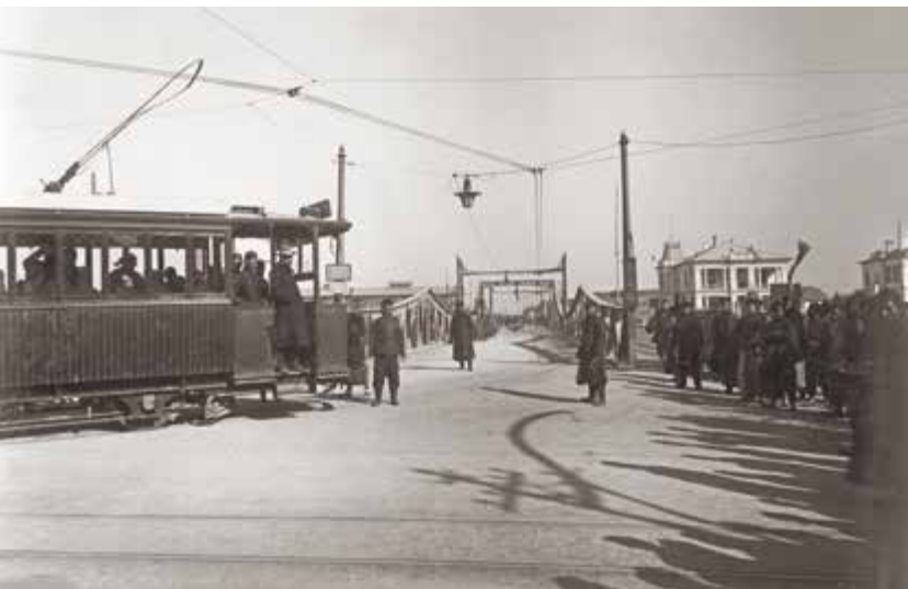
为电车过海河而修建的平开式铁桥——金汤桥，桥址上原为一座木船搭建的浮桥，称为东浮桥。摄于1906年，出自比利时根特大学档案馆保存的天津比商电车电灯公司工程师内恩斯相册
