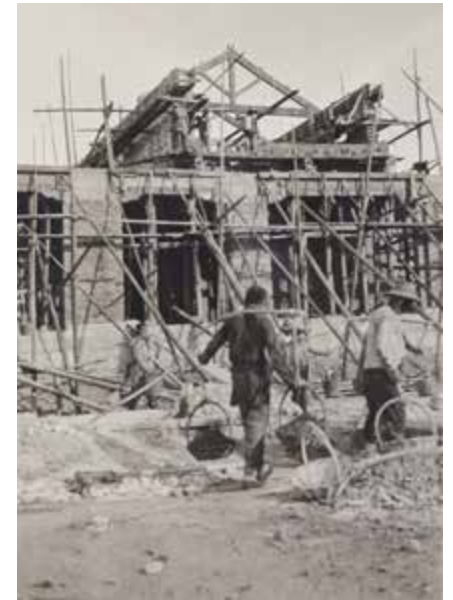
施工工地 Construction site
