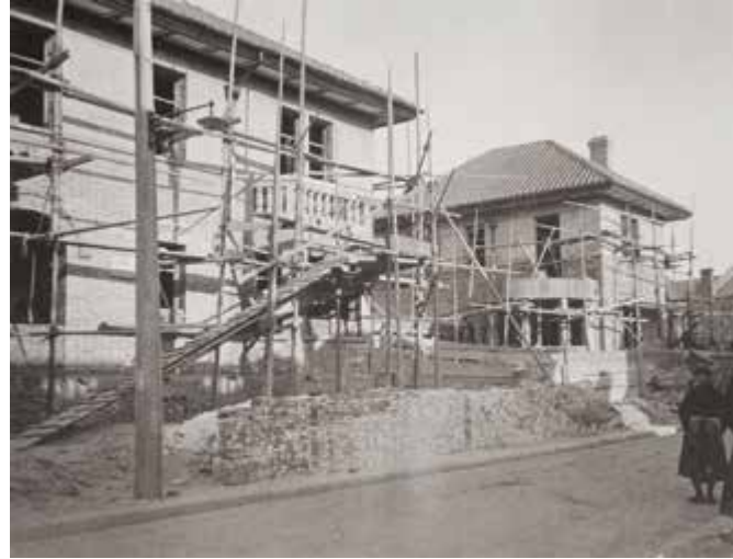
在建房屋 Building under construction
