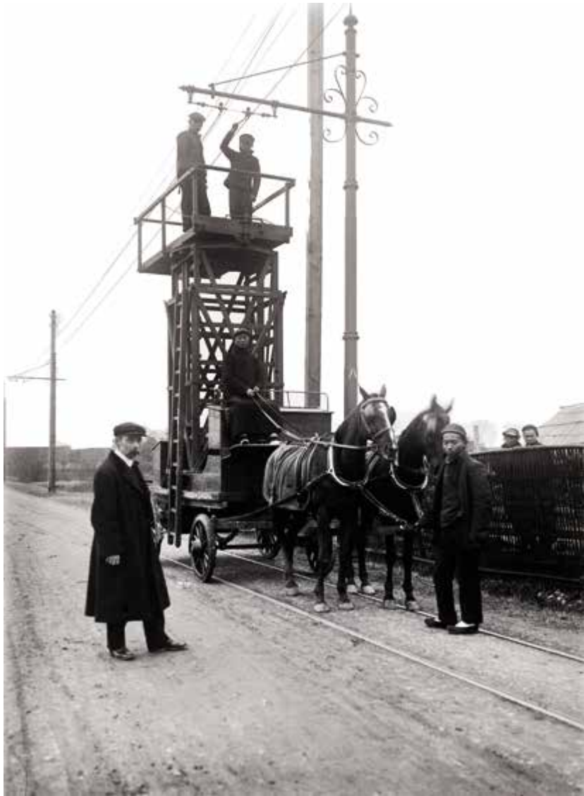
电车电灯公司员工检修电车线路。出自比利时根特大学档案馆保存的电车公司工程师内恩斯相册
